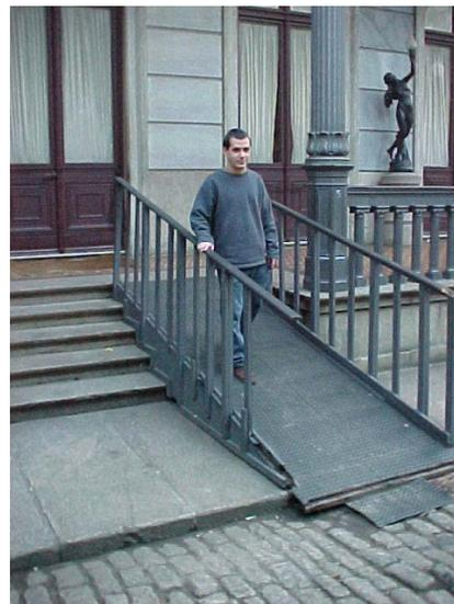
Figura 6: Rampa de acesso ao Museu da República: inclinação e posicionamento inadequados
